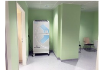
HEPA Guardian dans un couloir
